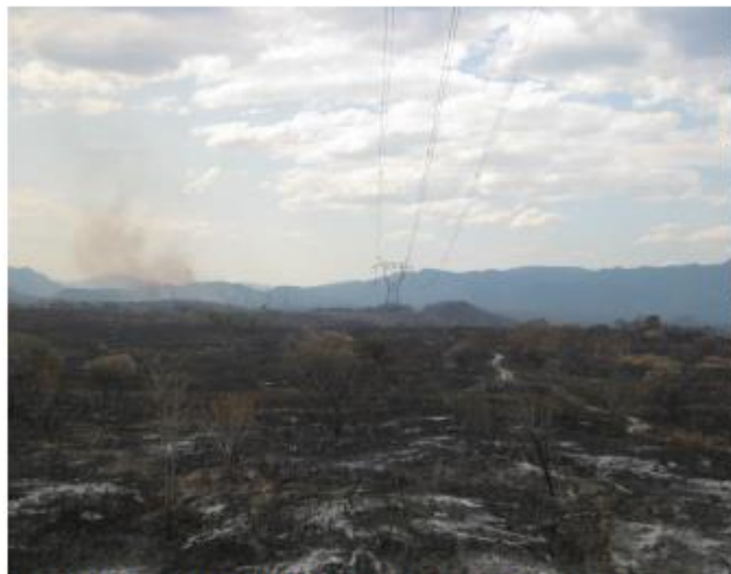
Figura 38 – Vão nº 25 atingido pela queimada dia 21/08/2014
