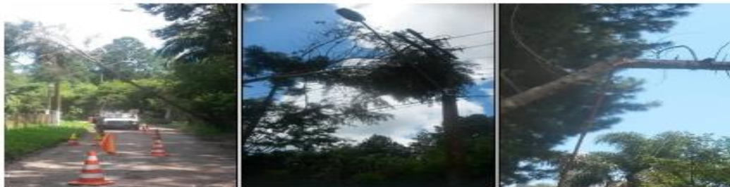
Queda de uma árvore de grande porte sobre a rede deixando fio de alta tensão partido na Estrada Sumaré S/N Parelheiros São Paulo
