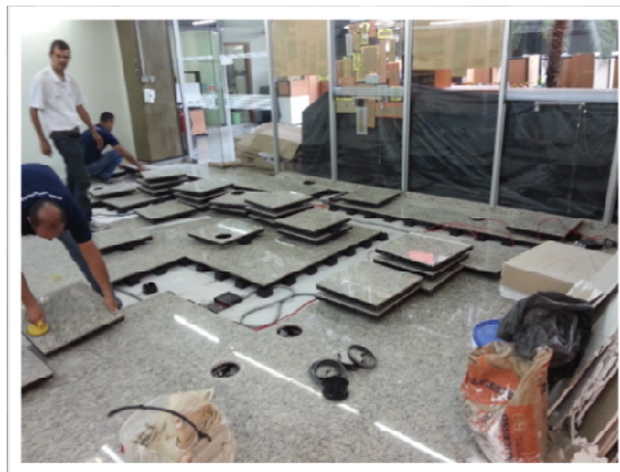
Imagem 8- instalação do sistema de piso elevado em polipropileno (Revestimento em granito padrão Amarelo Samoa polido)
